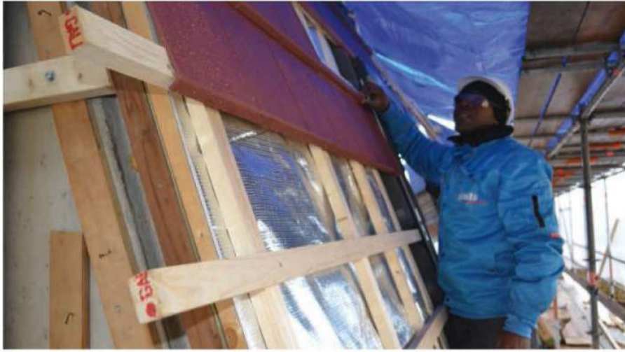
De dunne isolatiefolie kan op verschillende manieren worden toegepast, zoals bij een dakrenovatie in Rotterdam (links) en zelfs als reflecterende laag direct onder de vloerverwarming (rechts).
