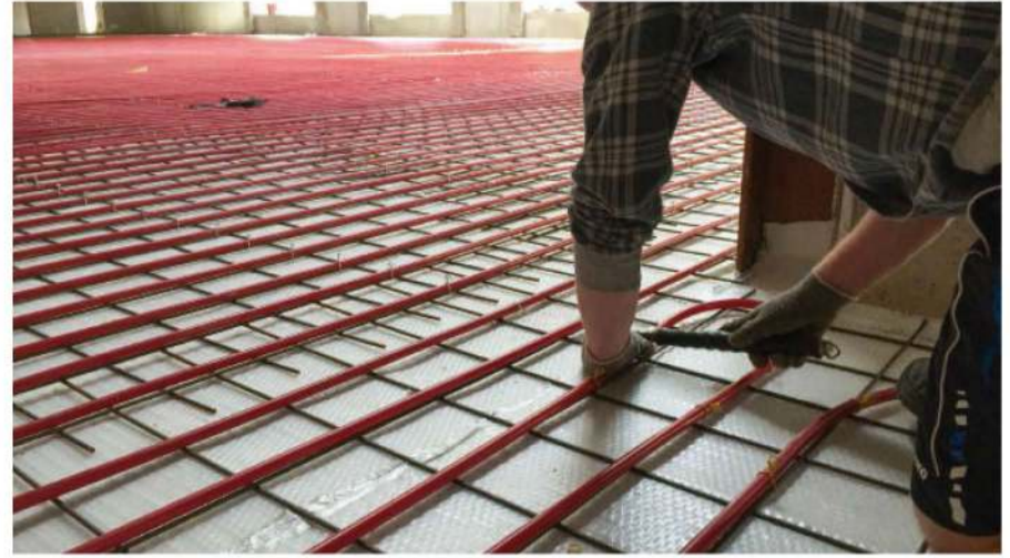
De dunne isolatiefolie kan op verschillende manieren worden toegepast, zoals bij een dakrenovatie in Rotterdam (links) en zelfs als reflecterende laag direct onder de vloerverwarming (rechts).
