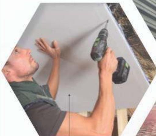
Airflex® Expert70, dampdicht, onder het dakbeschoot.
